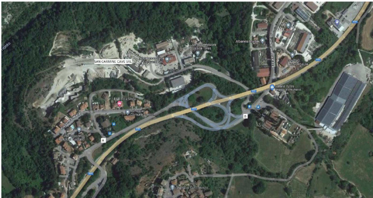
Impianto: "Sancarmine Cave srl" – Zona Industriale Santa Maria snc – Acquasanta Terme
