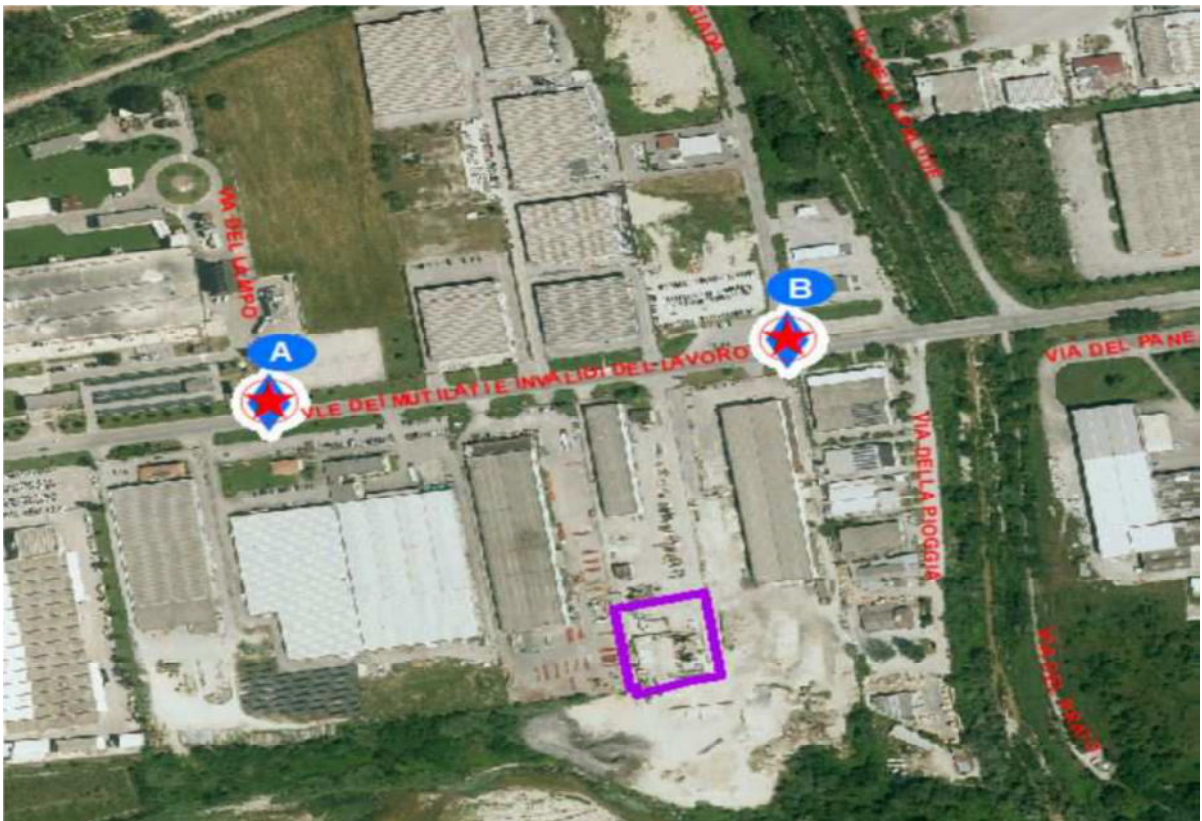
Impianto: "ABIT STRADE SRL" – Via dei Mutilati n. 87 Loc. Campolungo – Ascoli Piceno
