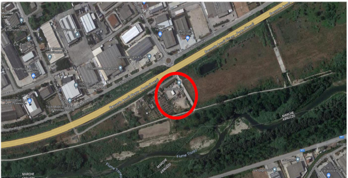
Impianto: “PICENAMBIENTE” – contrada Monterenzo n. 25 – Monteprandone
